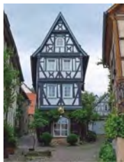
Bad Wimpfen - Fachwerkhaus in der Badgasse
